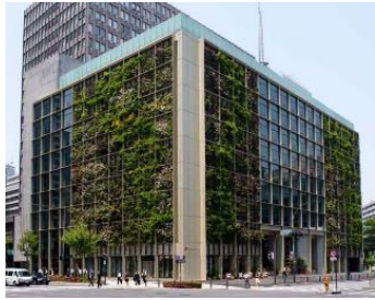
▲植物で覆われた本部ビル
